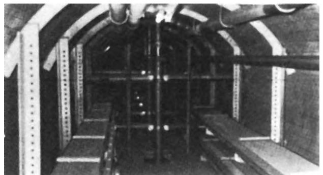
隧道工事に使用中の強力サポート
