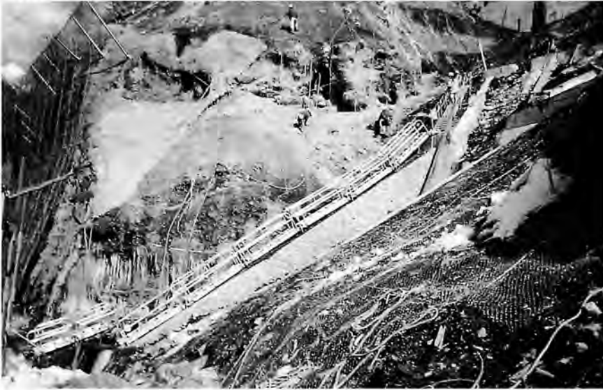
法面用作業現場の足場として…
