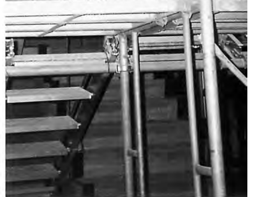
階段部補修工事用 階段として…
