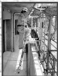
◀ベランダ側より
