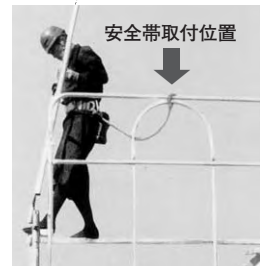
▲ 足場の先端部に建柵を取り付ける場合にはスカイガードの手すりへ安全帯を取り付ける。
