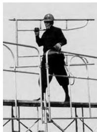
▲ 建柵を肩に担ぎ、片手はスカイガードの手すりにつかまりながら移動中。
