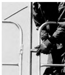
▲ 建柵に上部金具を突きあてます。
